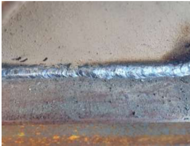
Figura 8.- Soldadura entre perfiles.
