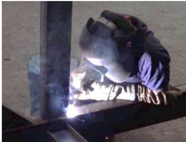
Figura 6.- Soldadura de los perfiles IPE-100 con IPE-160.
