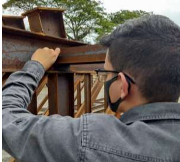
Figura 11.- Medición de espesores a mano con ayuda de la herramienta Galga para conexión perfil – perfil.
