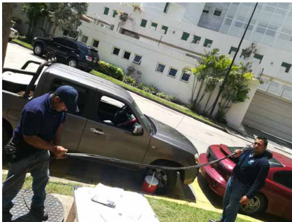
Figura 22. Proceso de tendido de fibra Fuente: Piñango. J. (2020)
