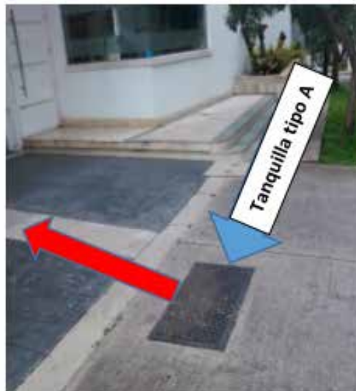
Figura 51. Tanquilla de acceso tipo A Fuente: Piñango. J. (2020)
