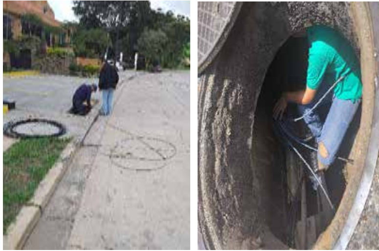
Figura 37. Implementacion de fibra troncal Fuente: Piñango. J. (2020)
