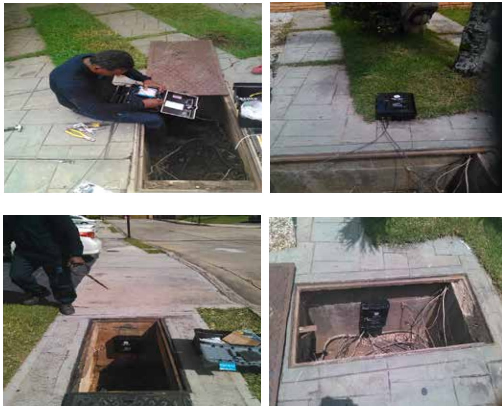
Figura 56. Asignación de cajas NAP en TH Villas del Country. Fuente: Piñango. J. (2020)
