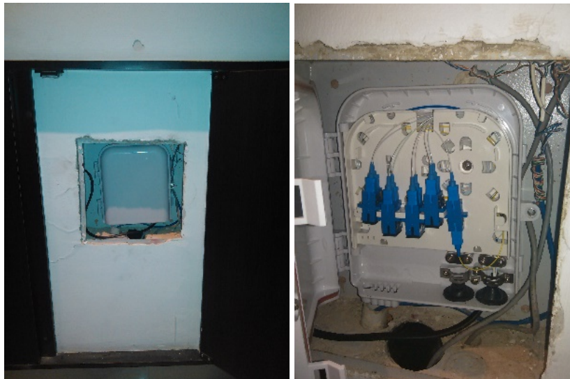
Figura 54. Instalacion de caja NAP Fuente: Piñango. J. (2020)
