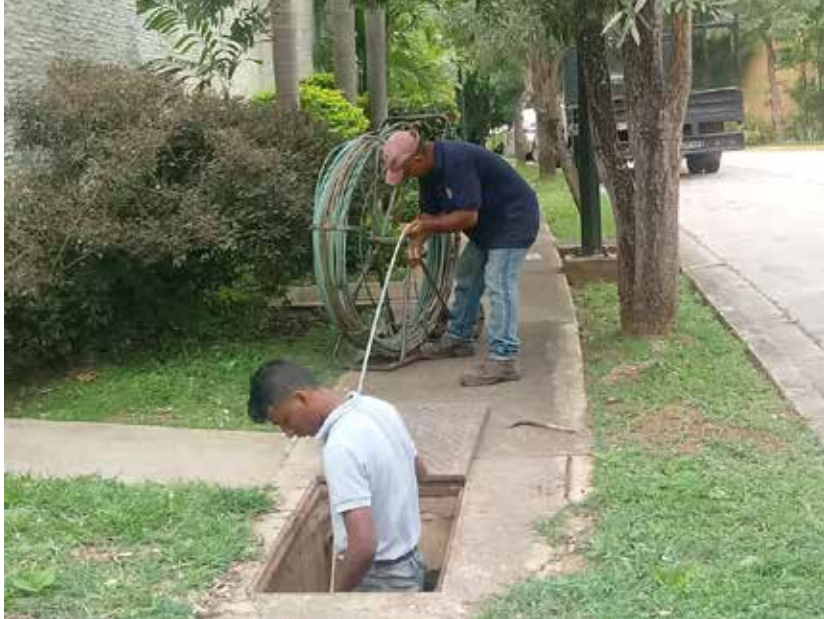
Figura 25. Uso de mariota para tendido de fibra Fuente: Piñango. J. (2020)
