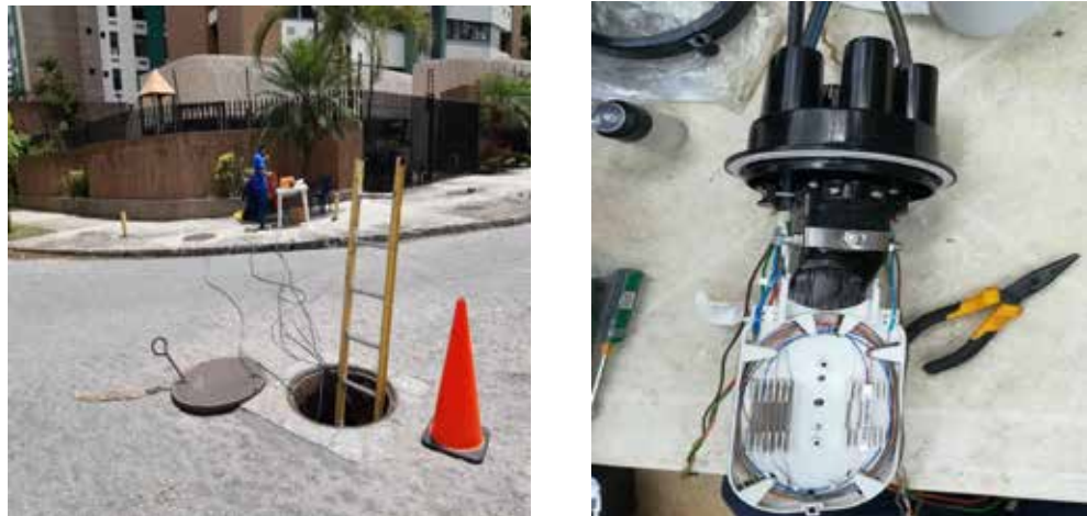
Figura 40. Empalme de manga de distribución
