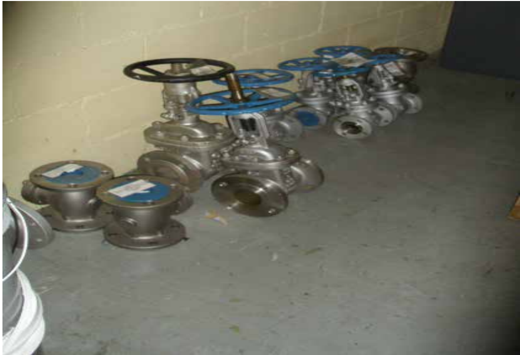
Figura 7: No Hay Suficiente Estantes y Quedan Repuestos en el Suelo
