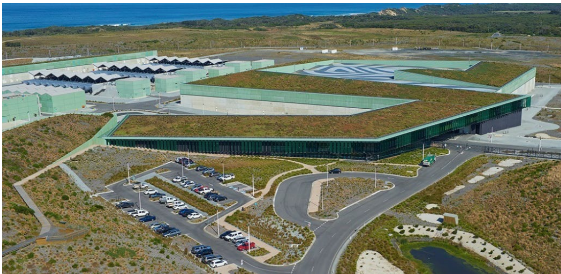
Figura 5: Planta desalinizadora victoriana. Fuente: State Government of Victoria (2022).
