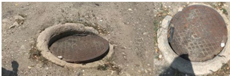
Figura 8: Imágenes de las acometidas de aguas blancas y aguas negras en el terreno en estudio.
