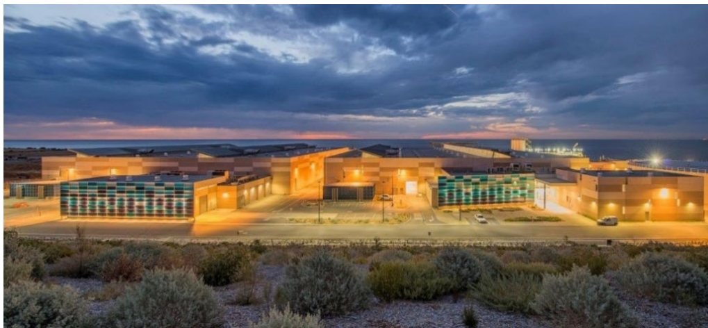
Figura 4: Planta desalinizadora de Adelaide.
