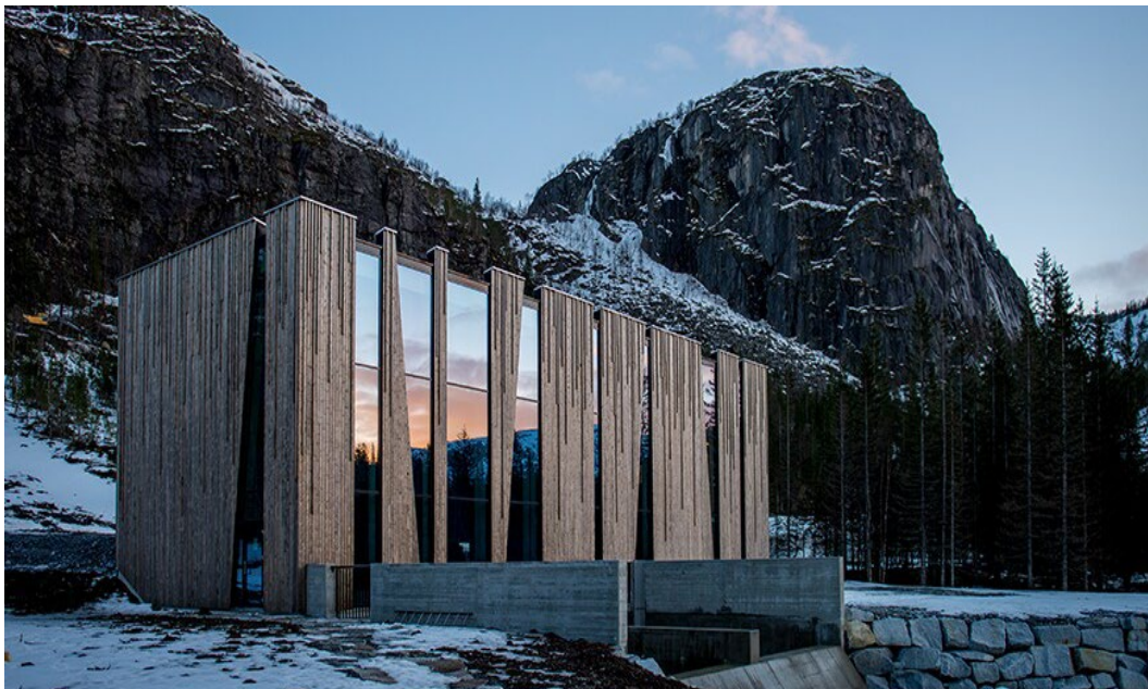
Figura 3: Central hidroeléctrica de Øvre Forsland. Fuente: Architect Magazine (2015).
