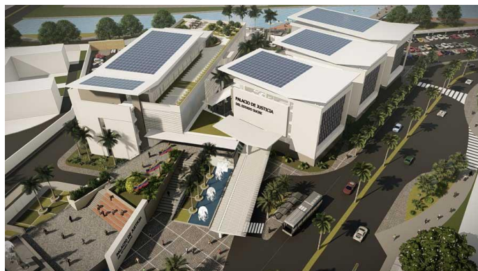
Figura 5. Vista Exterior de la edificación. Fuente: Rodríguez.
