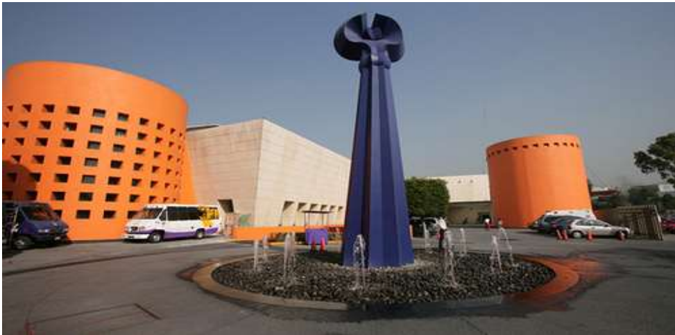
Figura 6. Perspectiva del acceso al CRIT. Fuente: http://www.mercuriospain.com/ (2000).
