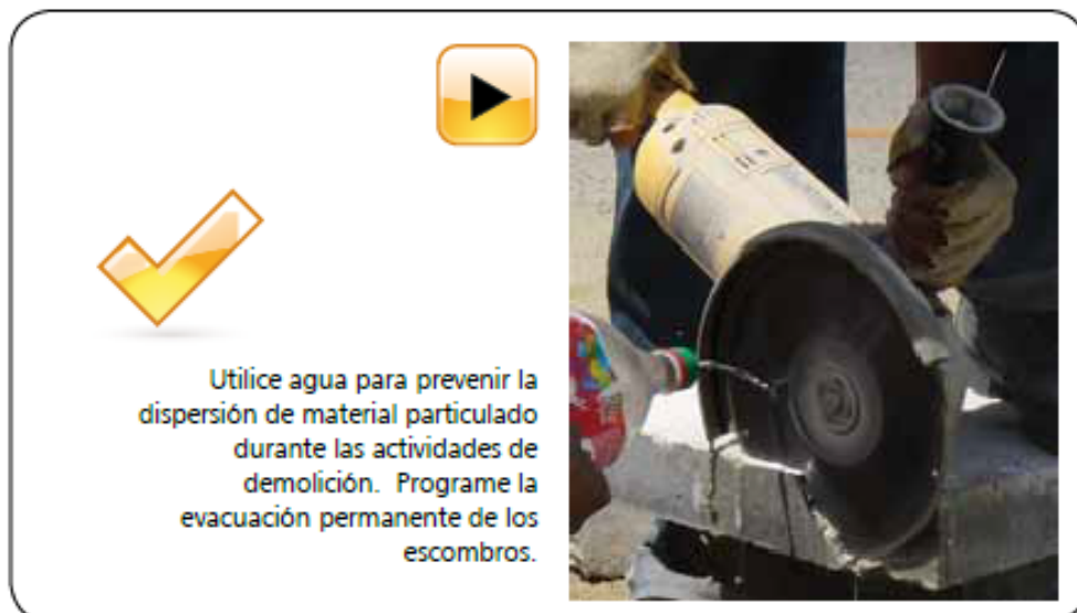
Figura 11. Control de emisión de particulado mediante el uso del agua.
