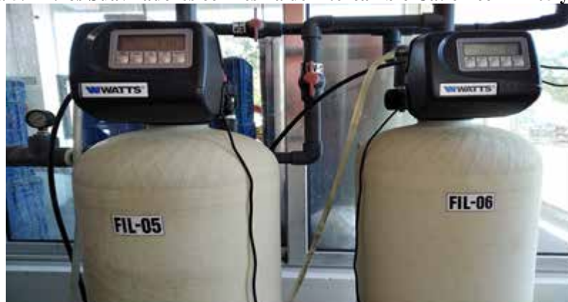
Figura 5. Filtros Suavizadores con resina de intercambio Catiónico FIL-05 y FIL-06
