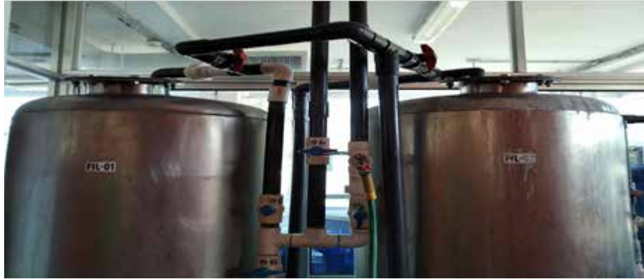
Figura 4. Filtros Pulidores Con Cartuchos de 5 micras FIL-03, FIL-04
