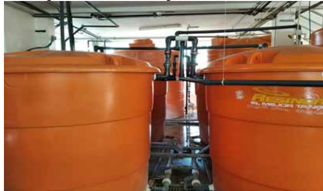
Figura 8. Tanques de Moderada Capacidad (3000 L) – T-05, T-06, T-07
