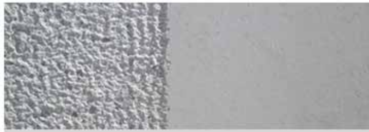
Figura 26 Comparación de acabados superficiales en concreto Fuente: Grupo Napresa (2019)
