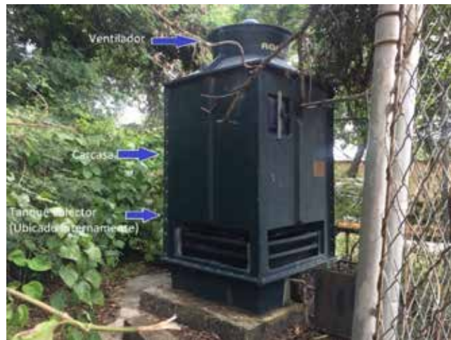
Figura 30. Partes visibles de la torre de enfriamiento.
