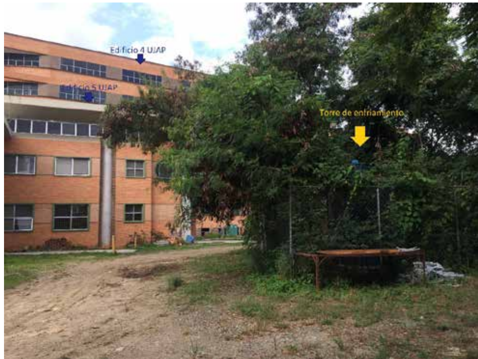
Figura 27. Localización de la torre de enfriamiento
