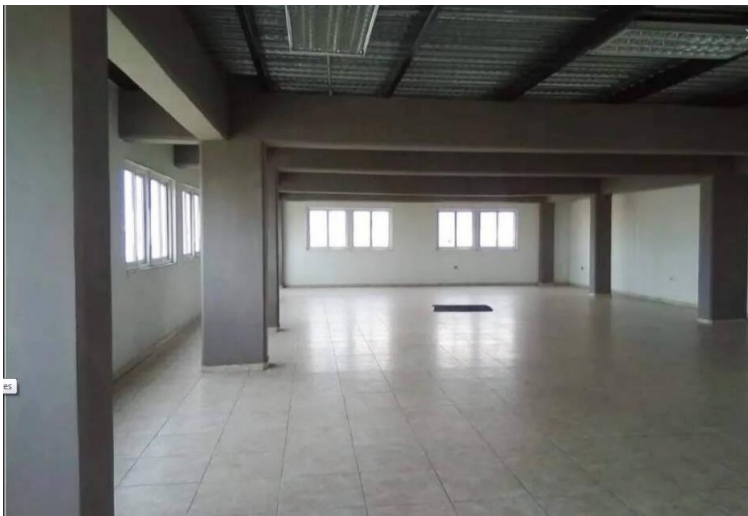
Figura 11 Grupo Distribuidor, C.A. (Sanitarios, Entrada de Portón, Infraestructura) Fuente: Empresa Grupo Distribuidor, C.A. (2023)
