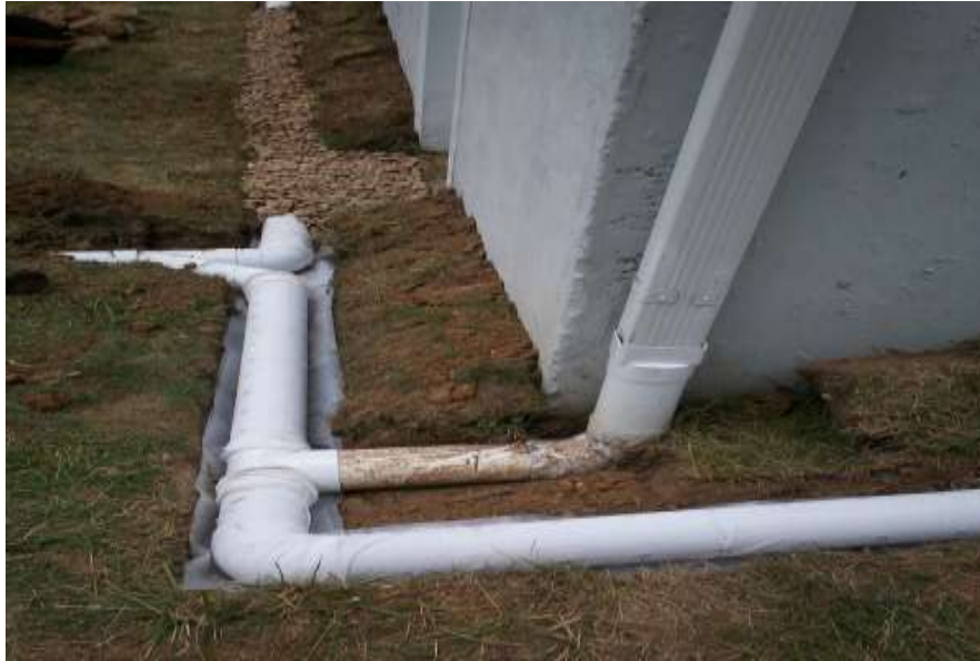
Figura 5. Sistema de drenaje de edificaciones
