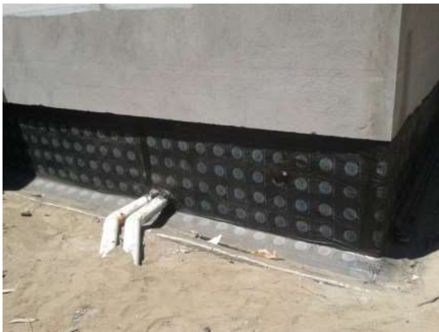
Figura 11. Impermeabilización en paredes
