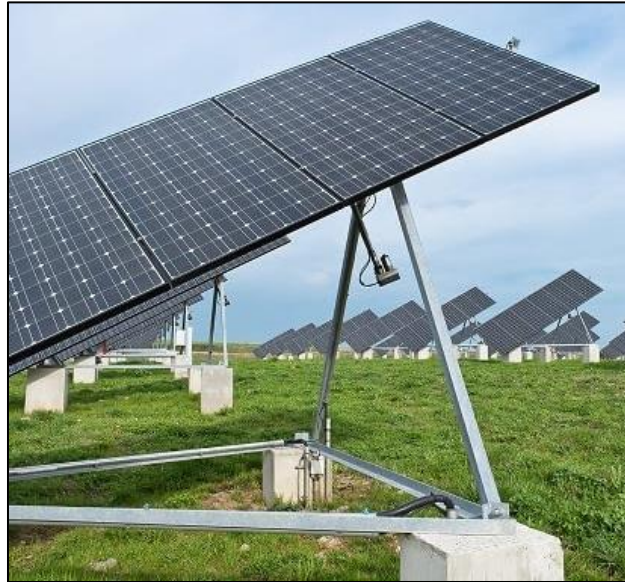
Figura 14: Seguidor solar de eje polar DEGER-S15
