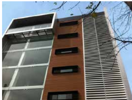
Figura 21: “Louvers” horizontales y Tablillas, Google. (2018)
