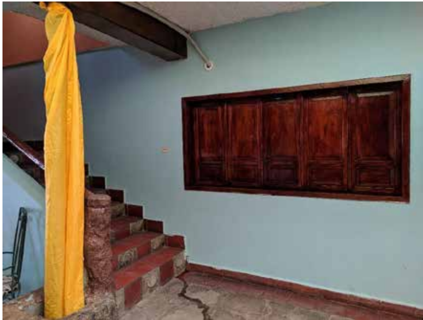
Fig. 1. Falta de señalización Fuente: Sanchez (2020)
