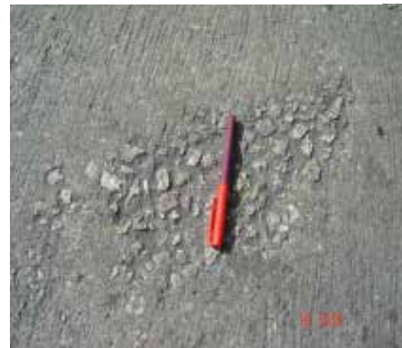
Fig 53. Foto 8. Cabezas duras (CD) (Fuente: Y. Apóstol, (2019))
