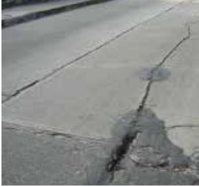
Fig 54.Foto 9. Levantamiento localizado (Fuente: Y. Apóstol, (2019))
