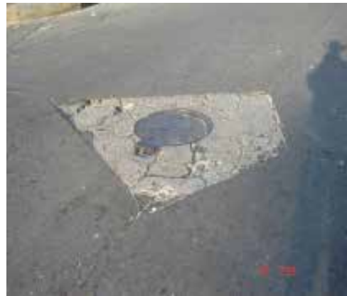
Fig 51. Foto 6. Grietas en pozos y sumideros -GA (Fuente: Y. Apóstol, (2019))
