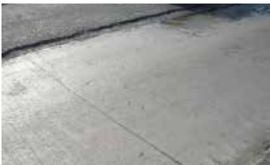
Fig 52. Foto 7. Pulimiento (PU) (Fuente: Y. Apóstol, (2019))
