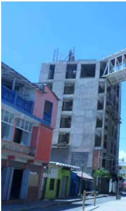
Figura 17. Fachada frontal Fuente: propia 2017.
