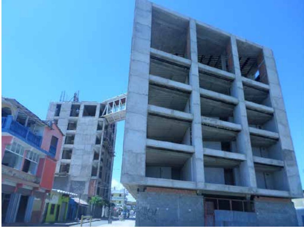
Figura 7. Fachada frontal Fuente: propia 2017.
