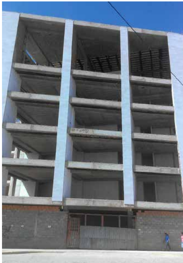
Figura 16. Fachada frontal Fuente: propia 2017.
