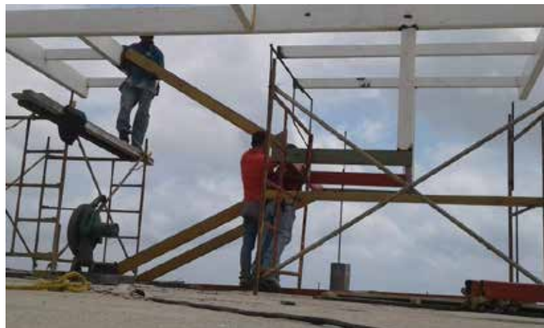
Figura 91. Vista de Azotea. Fuente: Propia (2018)
