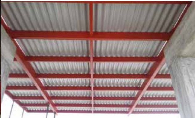
Figura 87. Vista de Azotea 2do Edificio Fuente: Propia (2018)
