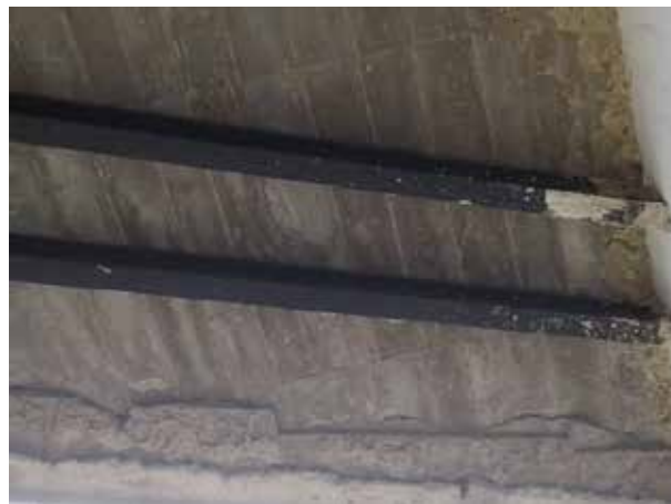
Figura 78. Vista de Refuerzo Fuente: Propia (2018)
