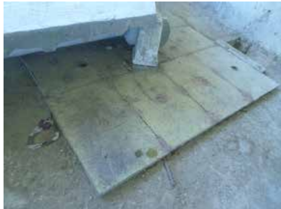
Figura 49. Vista Bases de Puente Fuente: Propia (2017)
