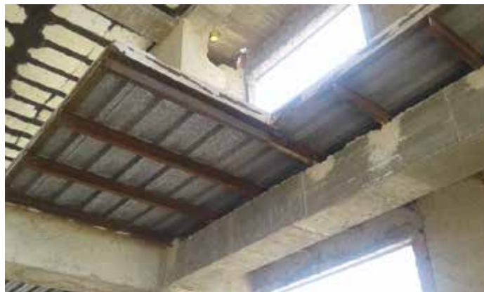
Figura 88. Vista de techo Fuente: Propia (2018)
