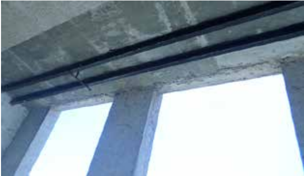
Figura 47 . Vista de Refuerzo Fuente: Propia (2017)
