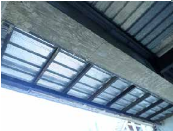
Figura 50. Vista de techo Fuente: Propia (2017)
