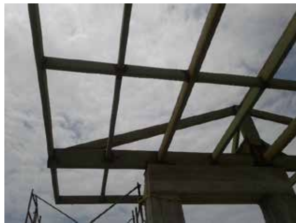
Figura 73. Vista de azotea 2do Edificio Fuente: Propia (2018)
