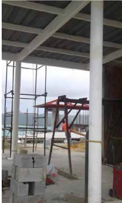
Figura 86. Vista de Azotea Fuente: Propia (2018)
