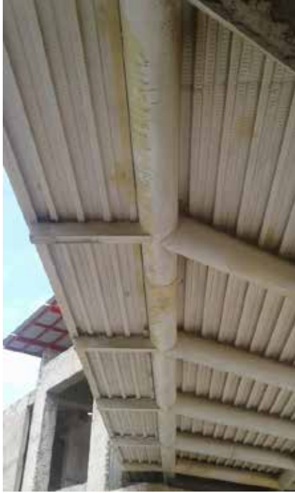
Figura 89. Vista de techo puente. Fuente: Propia (2018)
