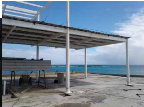
Figura 62. Vista de Azotea Fuente: Propia (2018)
