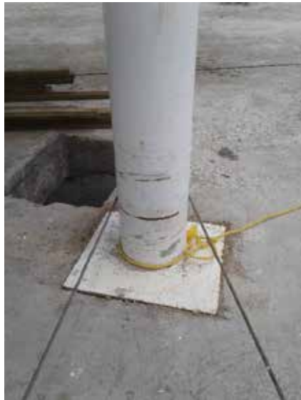
Figura 75. Vista de azotea Fuente: Propia (2018)
