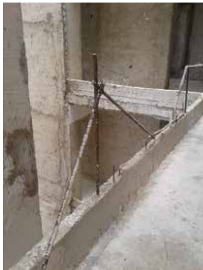
Figura 77. Vista de Acero 2do edificio Fuente: Propia (2018)
