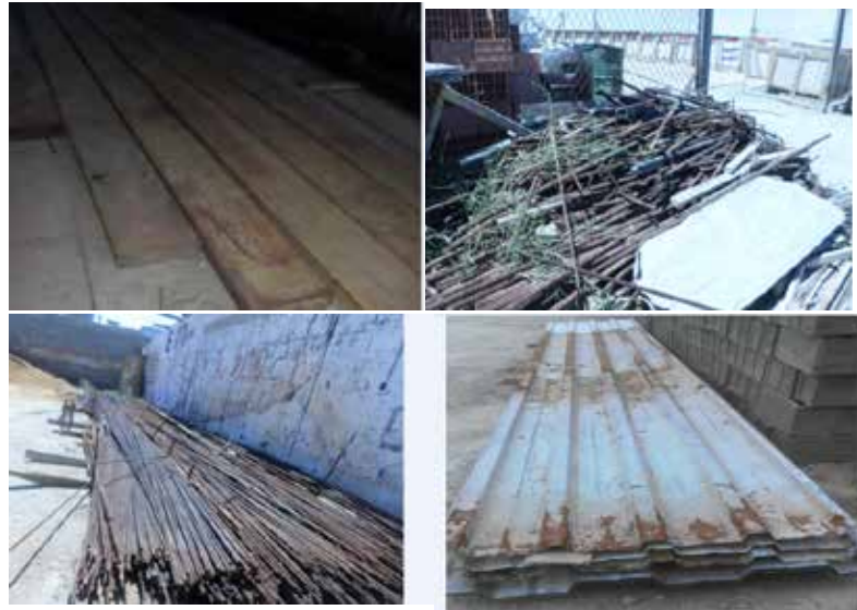
Figura 23 . Disposición a la intemperie y sobre el suelo el acero, cabillas y cubierta de techo.
