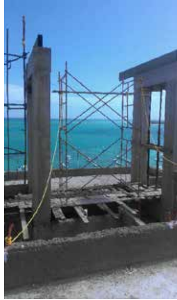
Figura 54. Vista de Azotea 2do edificio Fuente: Propia (2017)
