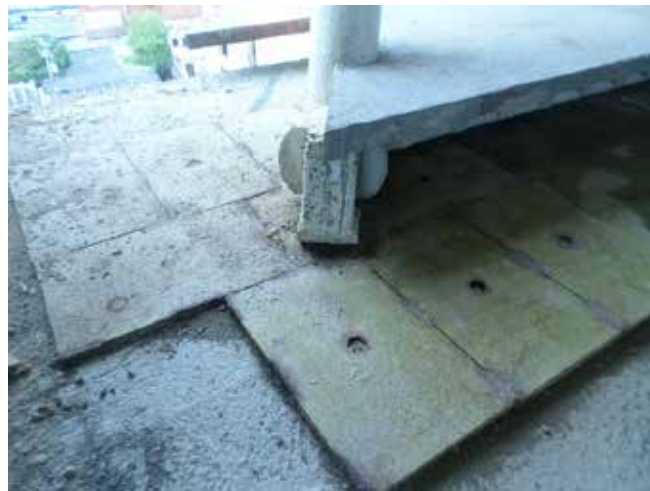
Figura 65. Vista de Bases de Puente Fuente: Propia (2018)
