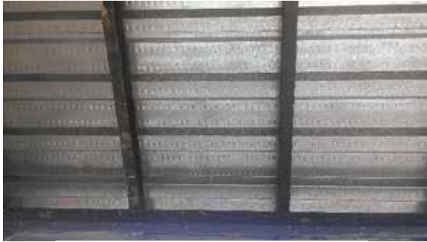
Figura 57. Vista de Techo Fuente: Propia (2017)
