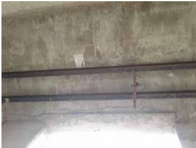
Figura 74. Vista de Refuerzo Fuente: Propia (2018)
