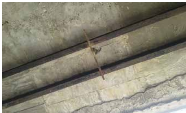
Figura 85. Vista de Acero de Refuerzo Fuente: Propia (2018)
