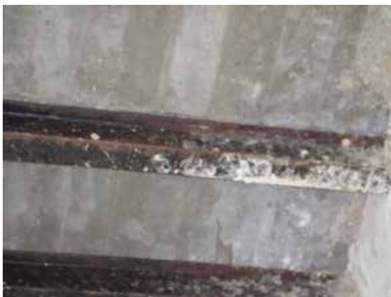
Figura 68. Vista de Refuerzo Fuente: Propia (2018)
