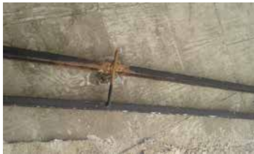
Figura 82. Vista de Acero de Refuerzo Fuente: Propia (2018)
