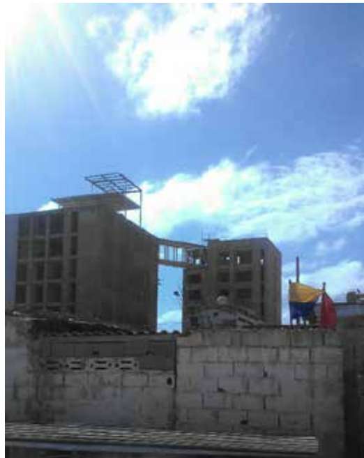
Figura 9. Fachada norte Fuente: propia 2017
