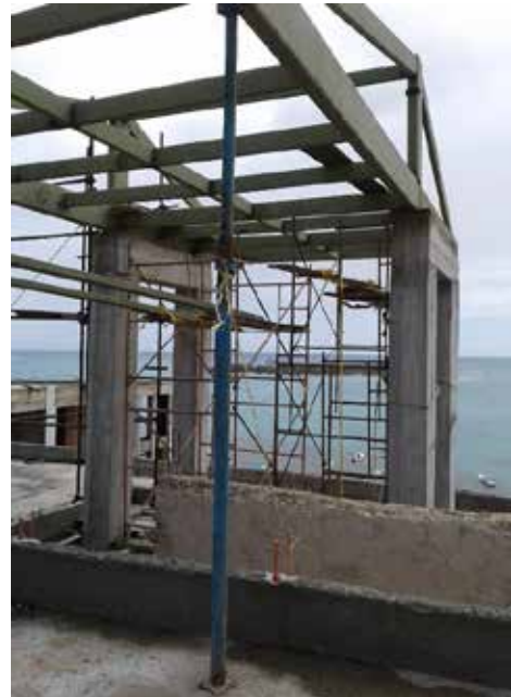
Figura 64. Vista de azotea 2do edificio Fuente: Propia (2018)
