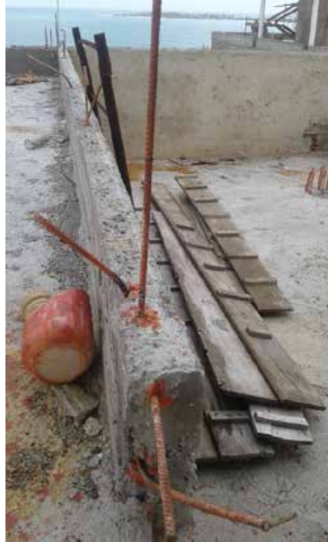
Figura 90. Vista de Acero de refuerzo. Fuente: Propia (2018)
