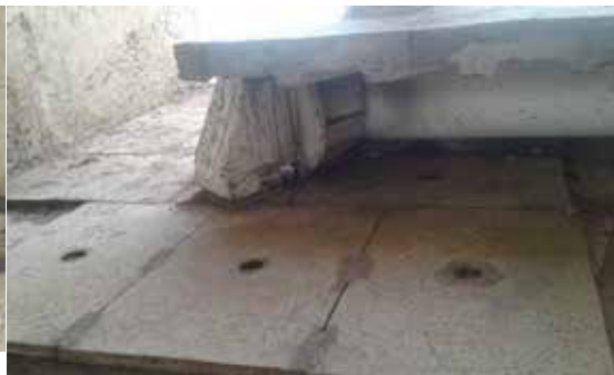
Figura 83. Vista de Base de puente Fuente: Propia (2018)
