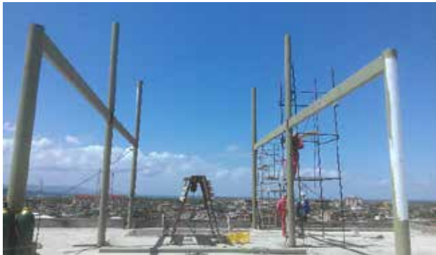
Figura 45 . Vista en Azotea Fuente: Propia (2017)
