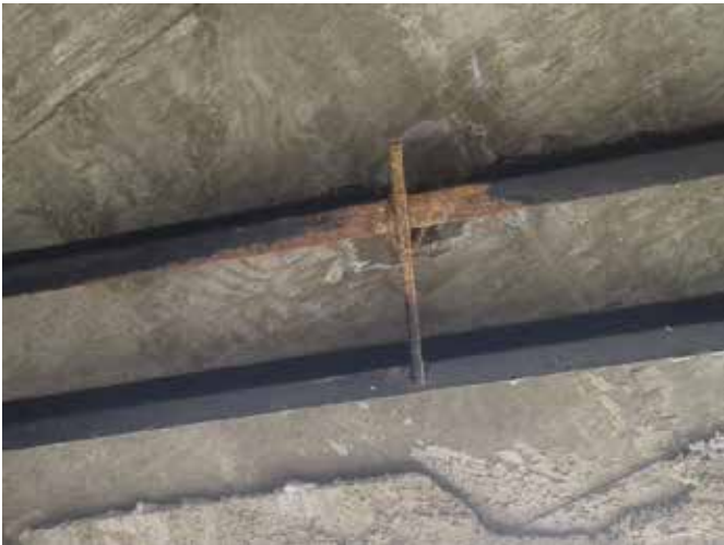
Figura 71. Vista de Refuerzo Fuente: Propia (2018)
