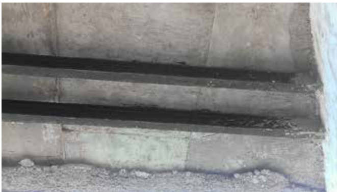
Figura 58. Vista de Refuerzo Fuente: Propia (2017)
