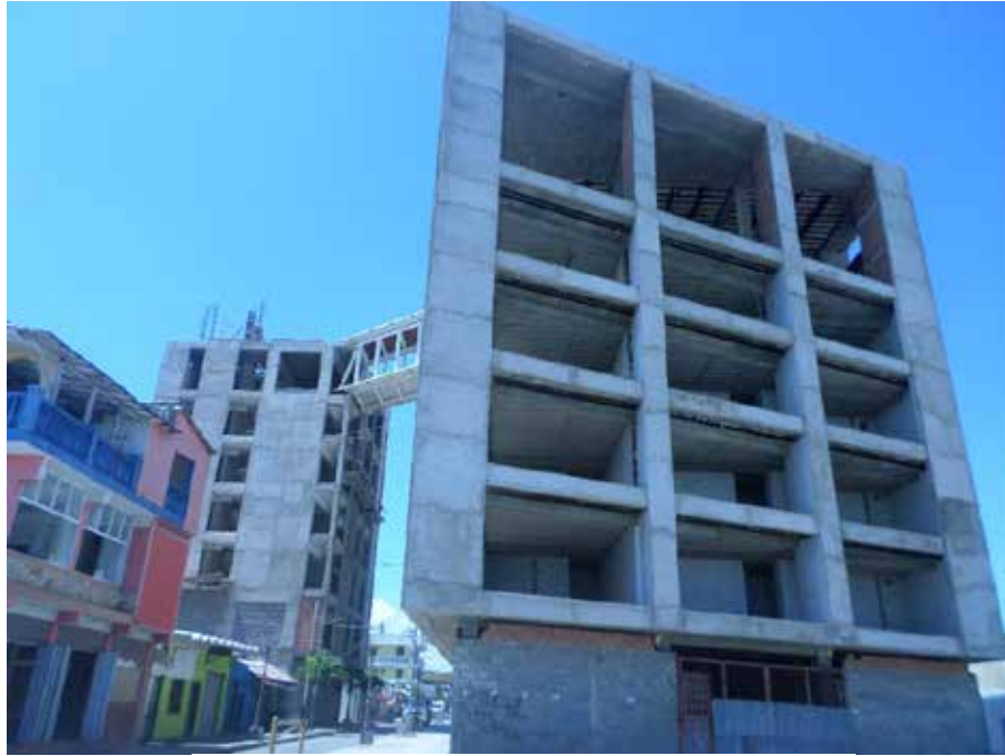
Figura 51. Vista de ambas edificación Fuente: Propia (2017)
