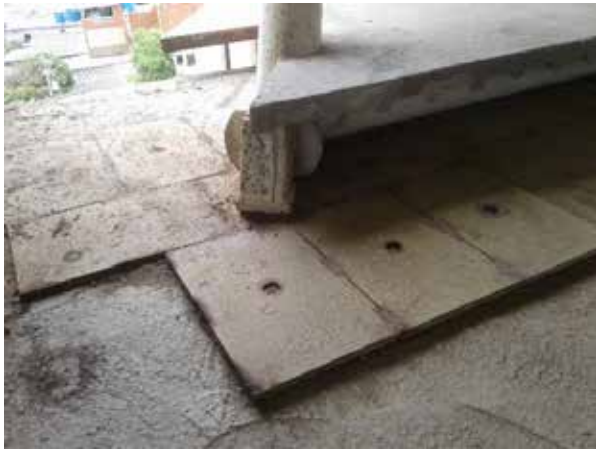
Figura 70. Vista de Base de Puente Fuente: Propia (2018)
