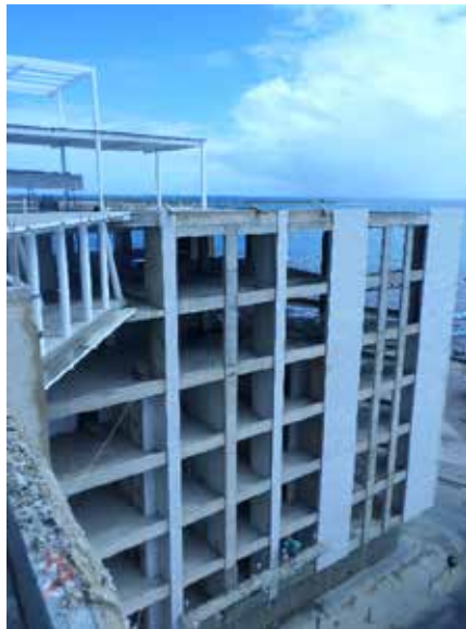
Figura 11. Fachada Sur del edificio 1 Fuente: propia 2017
