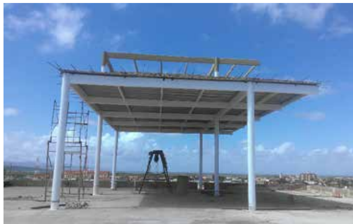
Figura 52. Vista de Azotea Fuente: Propia (2017)
