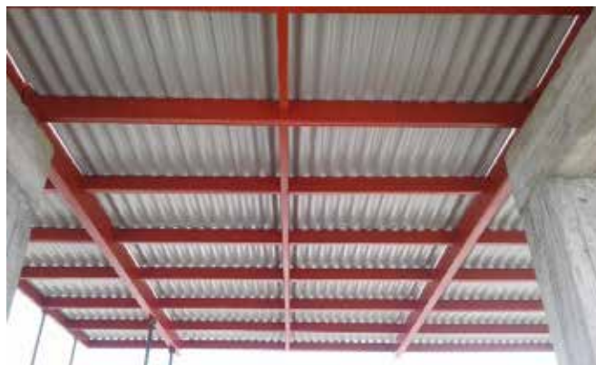
Figura 81. Vista de techo 2do edificio Fuente: Propia (2018)
