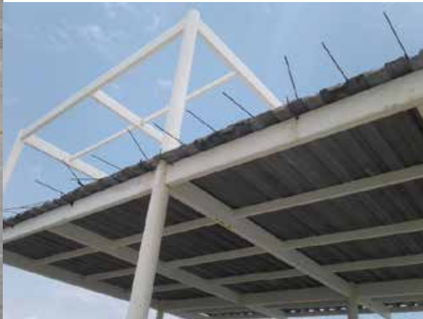
Figura 76. Vista de Azotea Fuente: Propia (2018)
