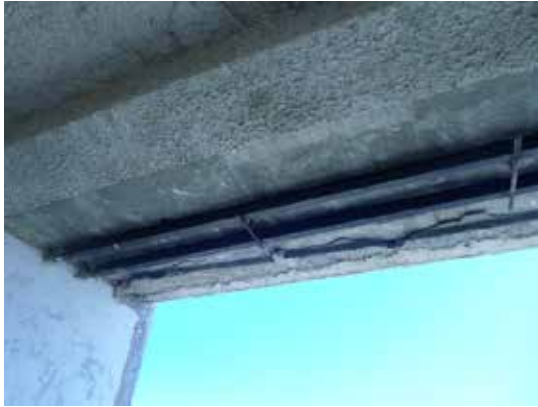
Figura 48. Vista refuerzo Fuente: Propia (2017)
