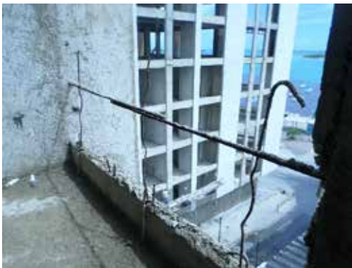
Figura 61. Vista de acero refuerzo Fuente: Propia (2018)
