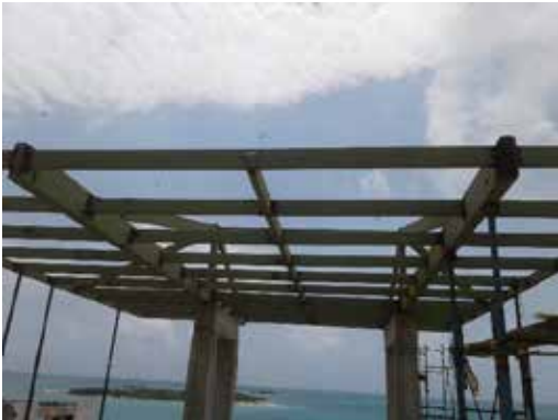
Figura 69. Vista de techo 2do edificio Fuente: Propia (2018)
