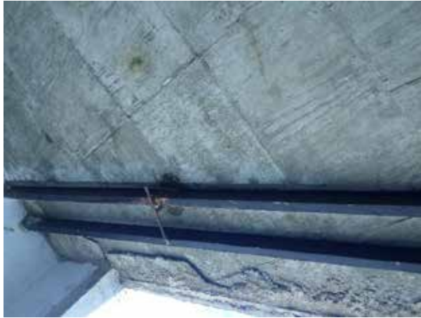
Figura 66. Vista de Refuerzo Fuente: Propia (2018)
