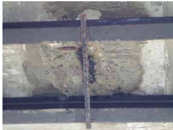
Figura 67. Vista de Refuerzo Fuente: Propia (2018)
