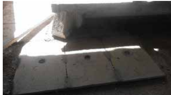
Figura 56. Vista de Refuerzo Fuente: Propia (2017)
