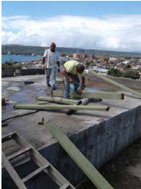
Figura 60. Vista de proceso de soldadura Fuente: Propia (2018)
