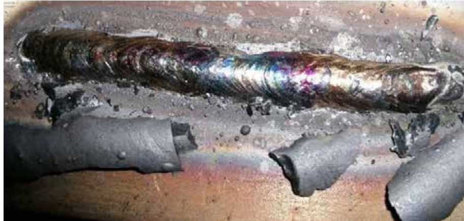
Figura 22: Escoria en Soldadura SMAW
