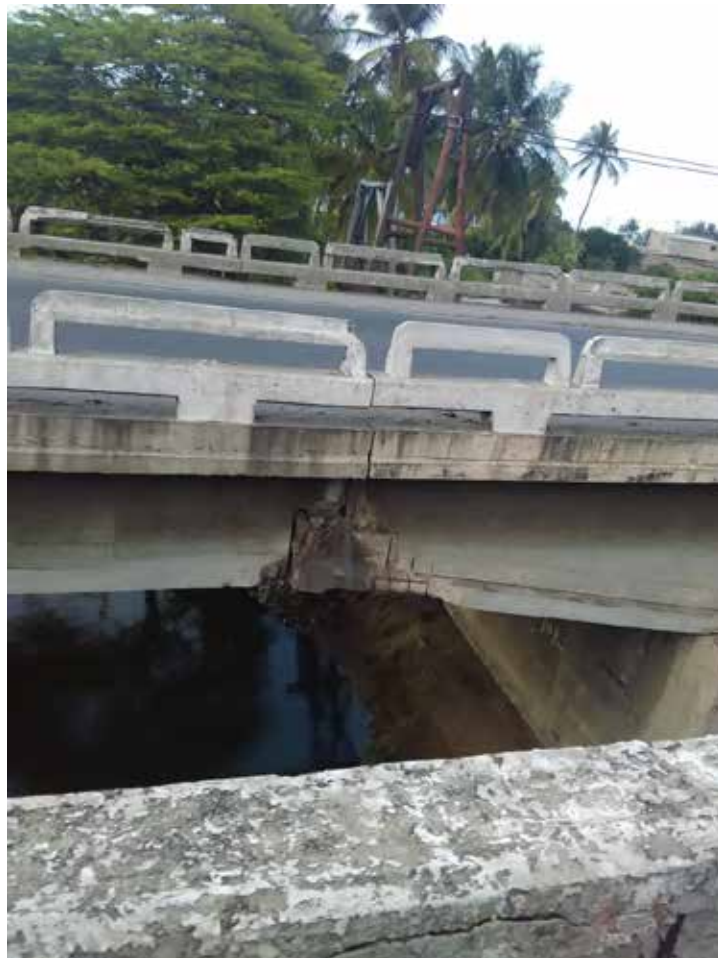
Figura 3 Puente cercano a Refinería el Palito.
