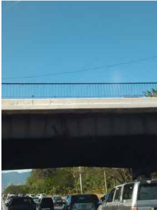
Figura 4 Puente en Distribuidor el Trigal, Valencia, Edo. Carabobo. Fuente: Larrazabal, 2017.
