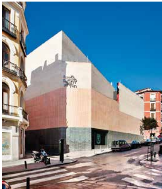
Figura 3: Fachada principal del mercado ubicada en la calle Augusto Figueroa. Fuente: http://www.laterizio.it/cil/progetti/136-mercato-di-san-anton-madrid-spagna.html (2011).
