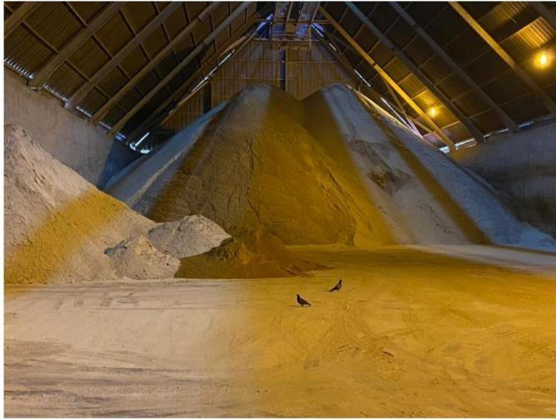
Figura 11: Amontonamiento de materia prima y almacén sin ventilación
