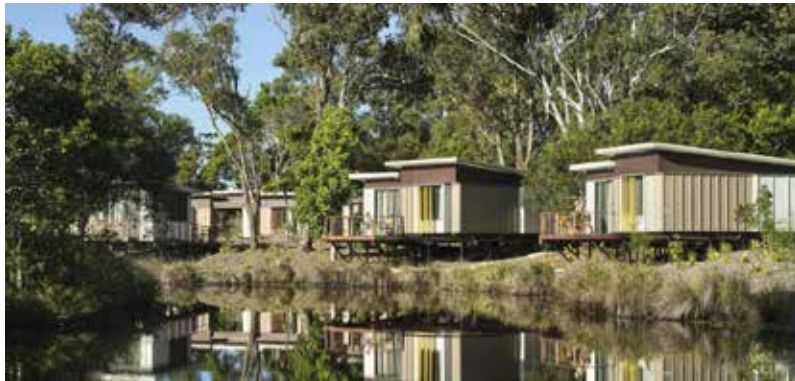
Figura 2. Vista exterior de las villas. Fuente: http://www.plataformaarquitectura.cl/cl/792273/elements-of-byron-shane-thompson-architects (2016)
