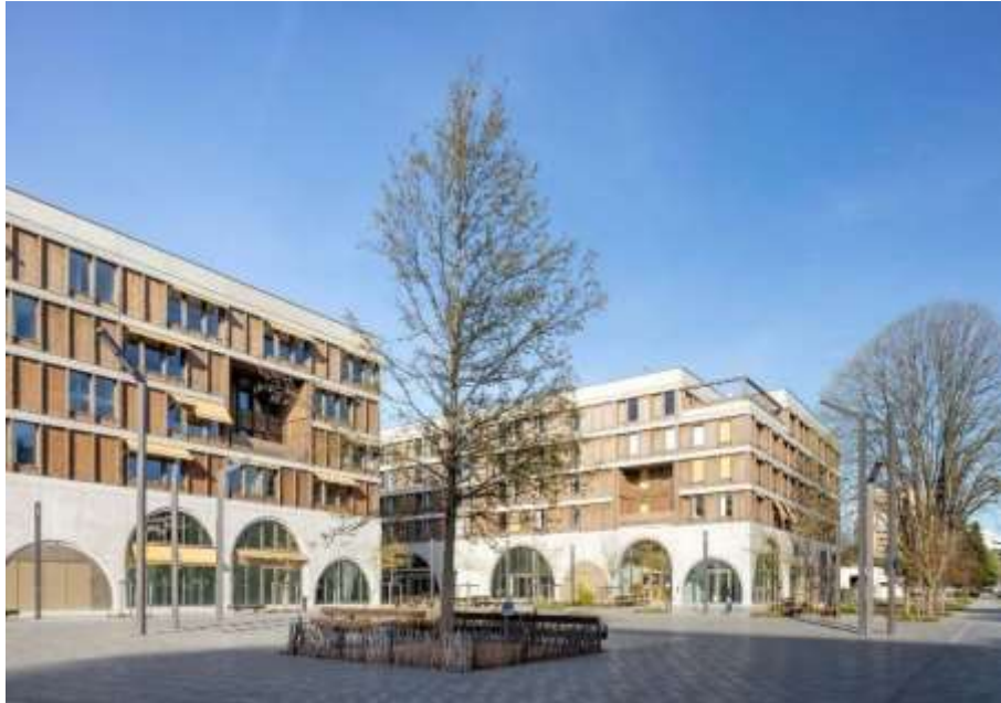
Figura 10 – vista desde plazoleta Fuente archdaily
