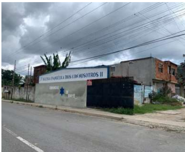
figura 3- condiciones de viviendas
