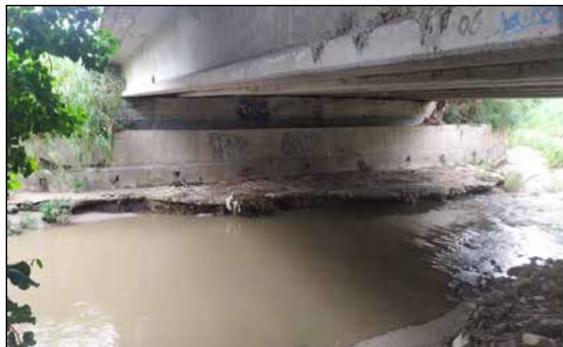
Figura 45: Luz, estribos, aletas y galibo del puente sobre la Av. 168 Salvador Feo la Cruz Este-Oeste. Fuente: Bolívar, H 2020
