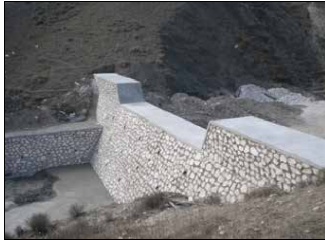
Figura 20: Dique de mampostería hidráulica.
