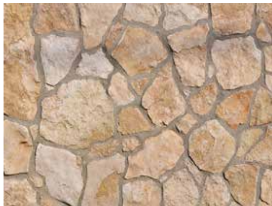
Figura 79. Fachada de Piedra. Fuente: https://es.pinterest.com/pin/294071050650177708/ (2016)
