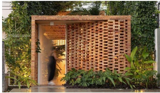
Figura 4. Cobertizo tropical. Fuente: ArchDaily, 2021.
