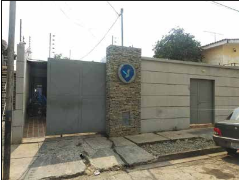
Figura 3: Instalaciones externas de Asiderapido C.A.
