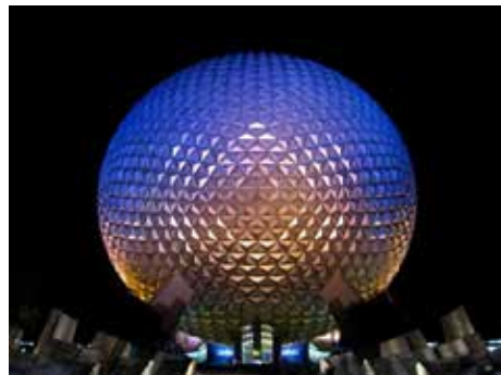
Imagen 22 Lamina de Alucobond fachada
