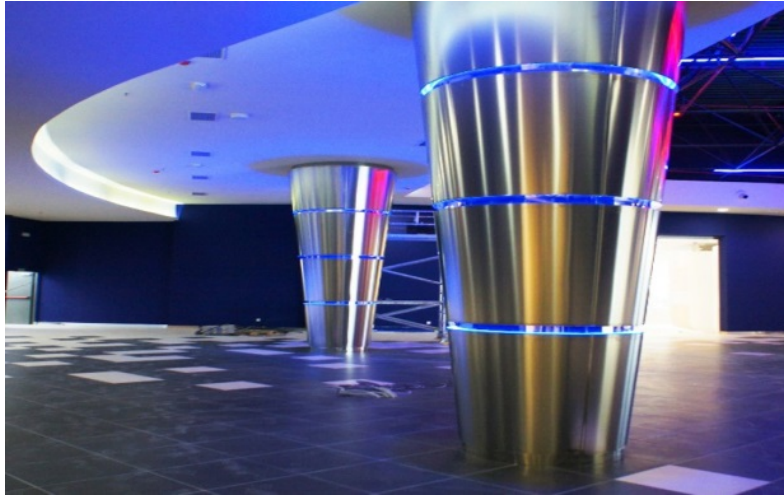
Imagen 26 Columna revestida de Acero Inoxidable
