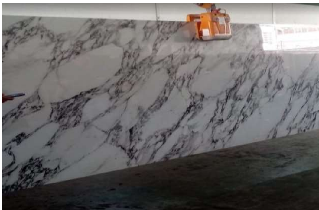
Figura N° 31. Elevación de lámina de cuarzo mediante la pinza.
