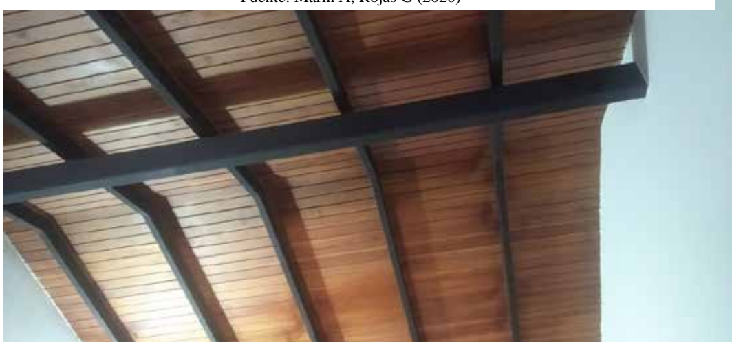
Figura 3. Vista del techo.
