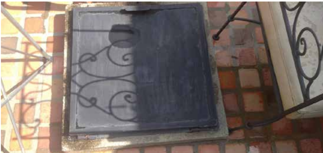
Figura 13. Vista de la boca de visita del estanque. Marin A, Rojas G (2020)
