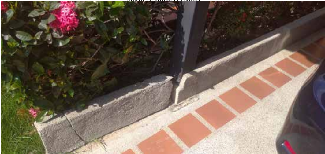
Figura 30. Muro entre viviendas. Marin A. Rojas G (2020)
