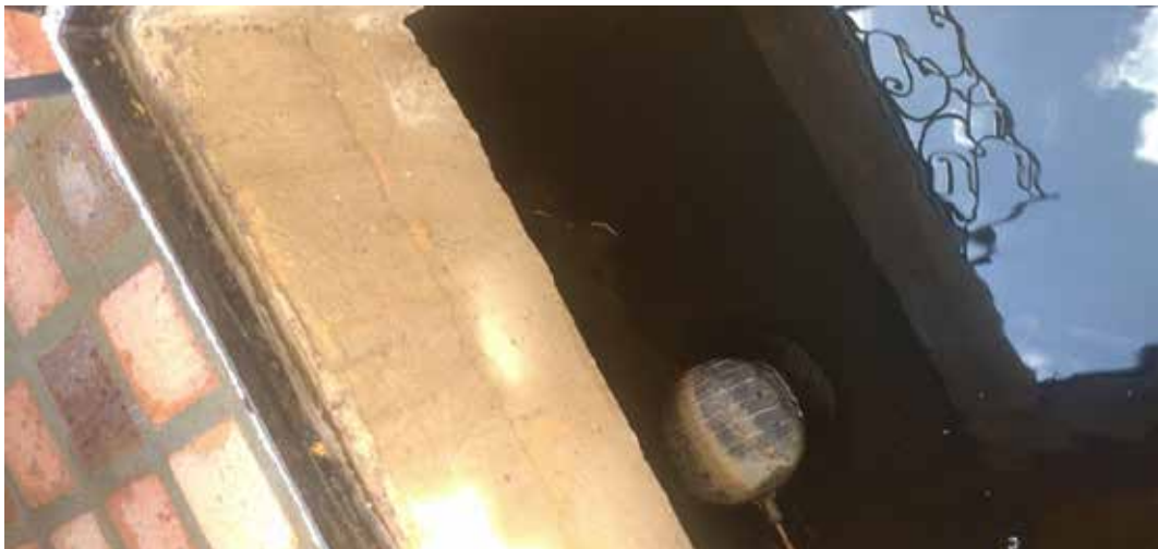
Figura 14. Flotante del estanque. Marin A, Rojas G (2020)
