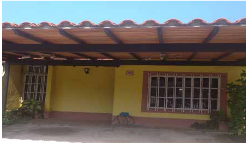
Figura 1. Vista frontal de la vivienda.
