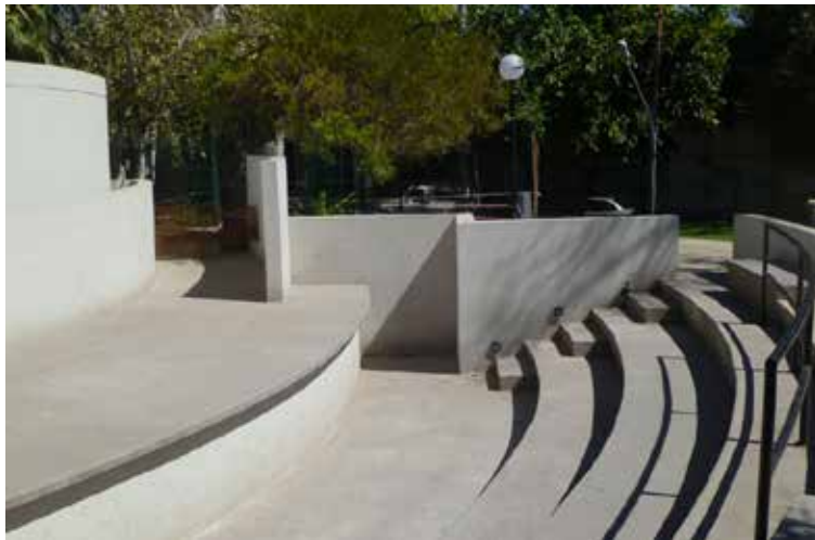
Figura 6: Anfiteatro del Acuario Municipal de Mendoza. Andia Arquitectos. Fuente: Andiaarquitectos.com (2011).
