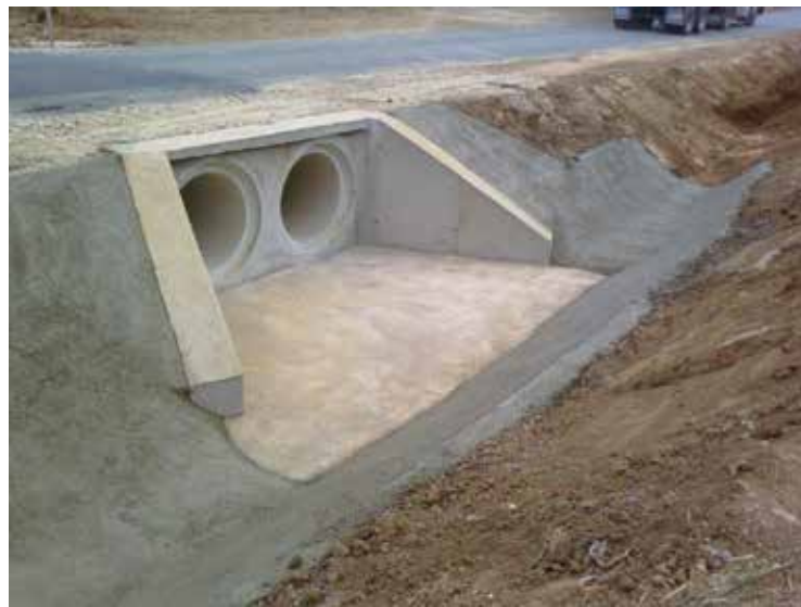
Figura 37: Drenaje Transversal de Vía
