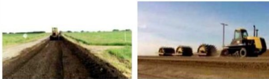
Figura 23. Etapas para la preparación de la Subrasante.
