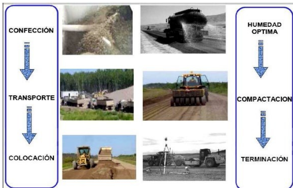
Figura 22. Etapas para la preparación de la Base
