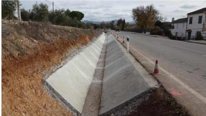
Figura 38: Drenaje Longitudinal de Vía
