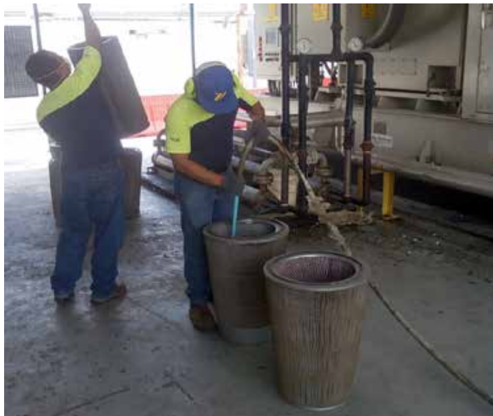
Figura 8. Filtros de admisión de aire del turbogenerador.
