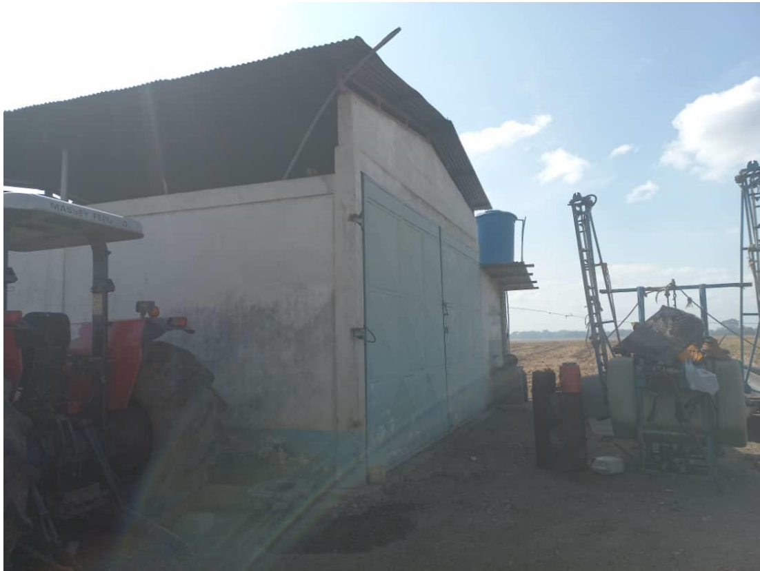
Figura 14. Galpón ubicado en la vivienda
