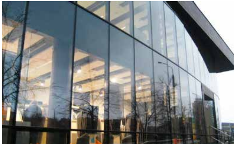
Figura 21: Vidrio semi polarizado, con perfiles de aluminio en color negro
