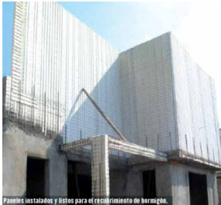
Figura 1: Avances estructurales de la obra Fuente: Molina Ruíz (2017)
