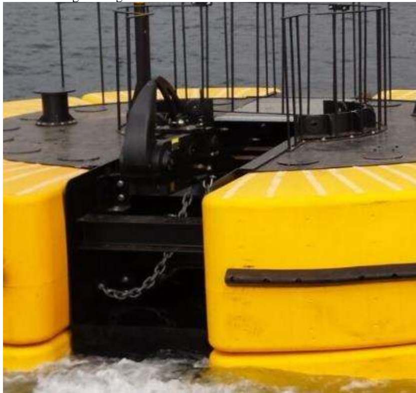
Figura 30. Gancho de desprendimiento rápido tipo individual instalado.
