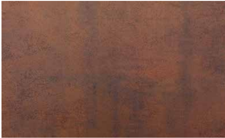
Figura 33. Revestimiento acero oxidado. Fuente: Depositphotos (2021)
