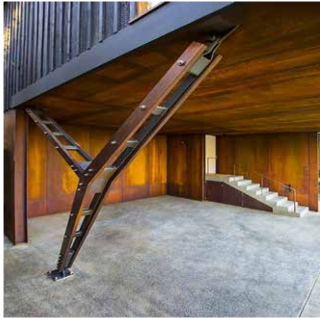
Figura 29. Rampa. Fuente: Pinterest (2021)
