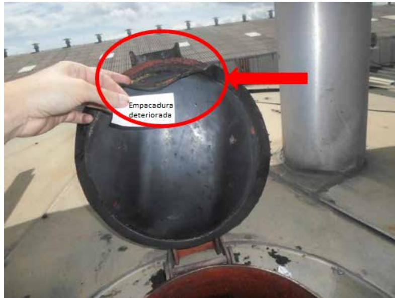
Figura 23: Mal estado empacadura
