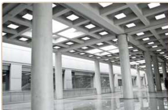
Figura 49: columnas cilíndricas obra limpia
