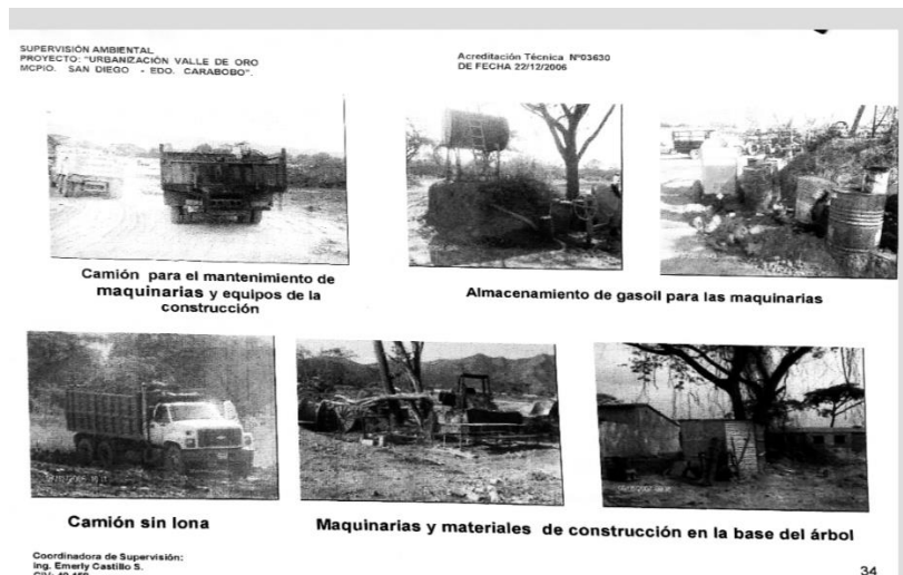
Figura 11 Registro fotográfico de la supervisión ambiental de del proyecto.
