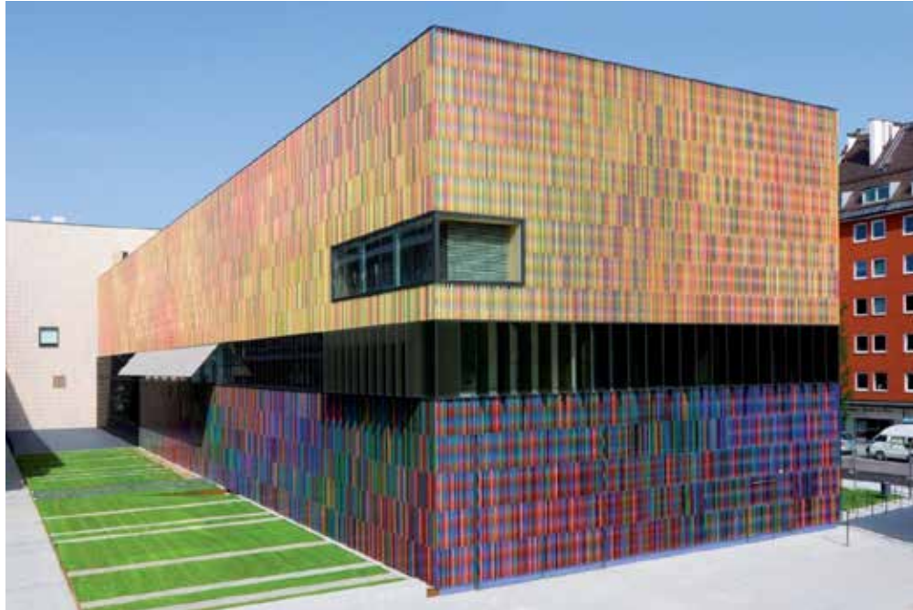
Figura 25. Fachadas ventiladas de Hunter Douglas (2019)
