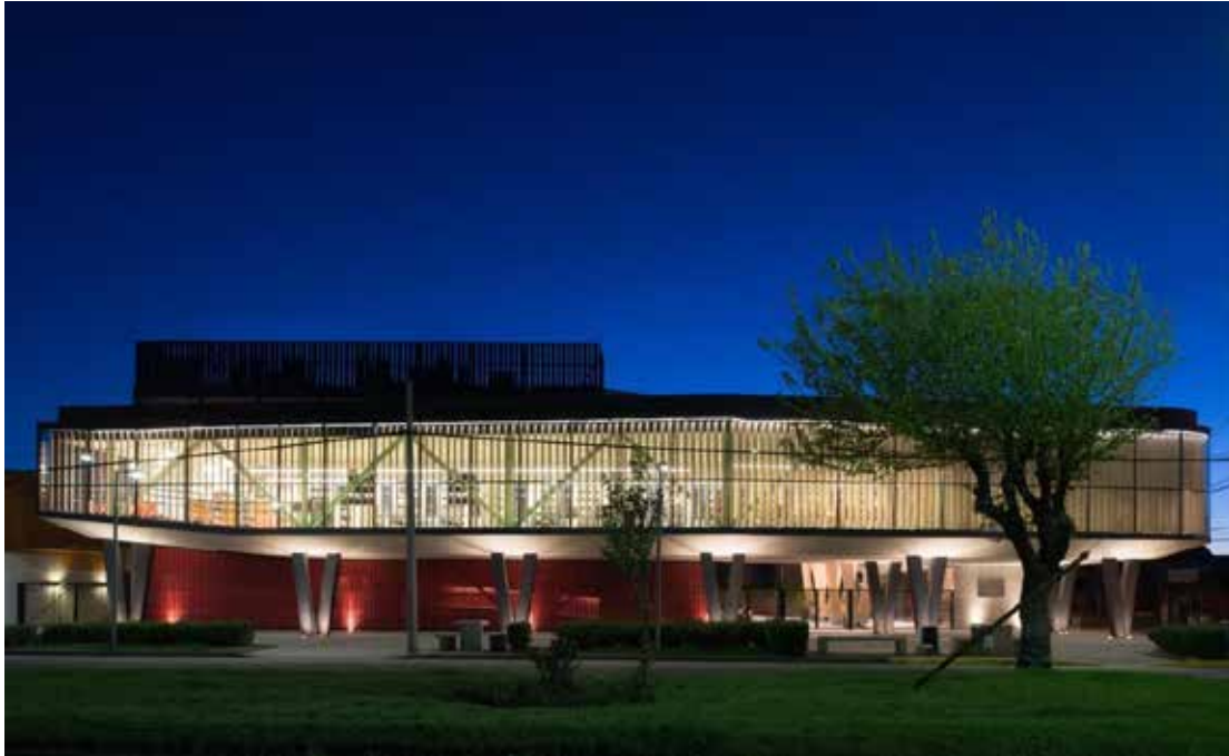
Figura 1. Centro Cultural Arauco.
