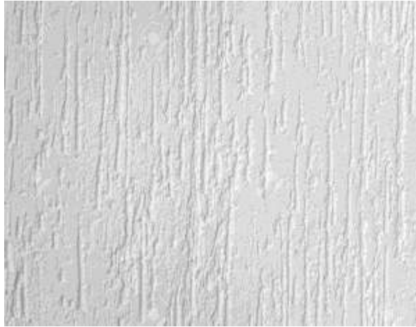
Figura 18 – Acabado de paredes en yeso.
