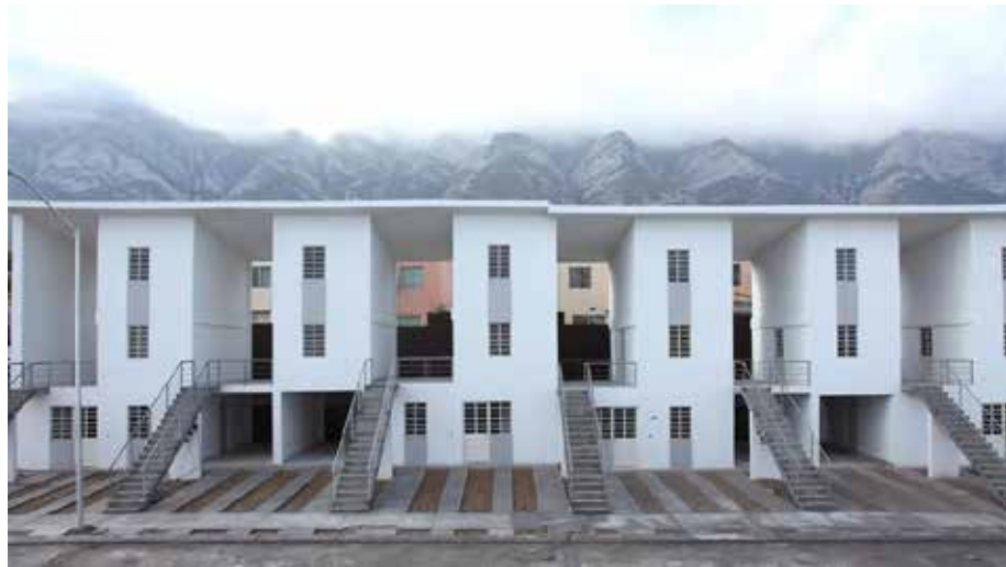
Figura 1. Conjunto Residencial – Vivienda Social, Monterrey, Mexico. Fuente: https://www.plataformaarquitectura.cl/cl/02-38418/elemental-monterrey (2010).
