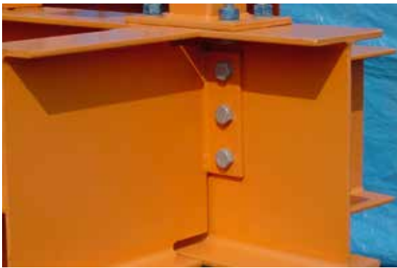
Figura7 Conexión de plancha extrema. Fuente: Díaz, H (2010)
