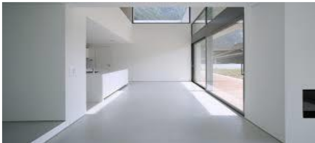
Grafico 10: Revestimiento de paredes internas con microcimento
