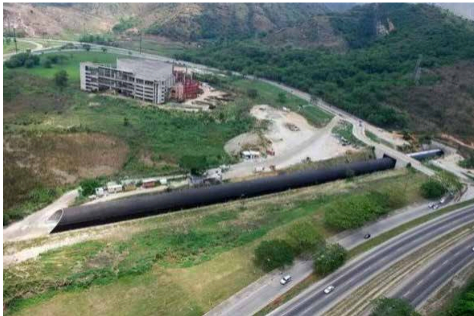
Figura 11. Via Ferrea en Construcción. (2018)
