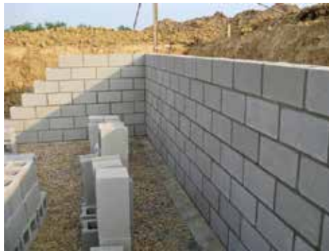
Figura 48: Construcción de sótano. Fuente:
