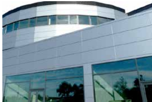
Figura 43: Uso del Stac Bond en fachada. Fuente:
