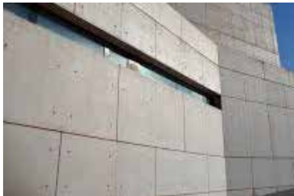
Figura 46: Hormigón armado en fachada
