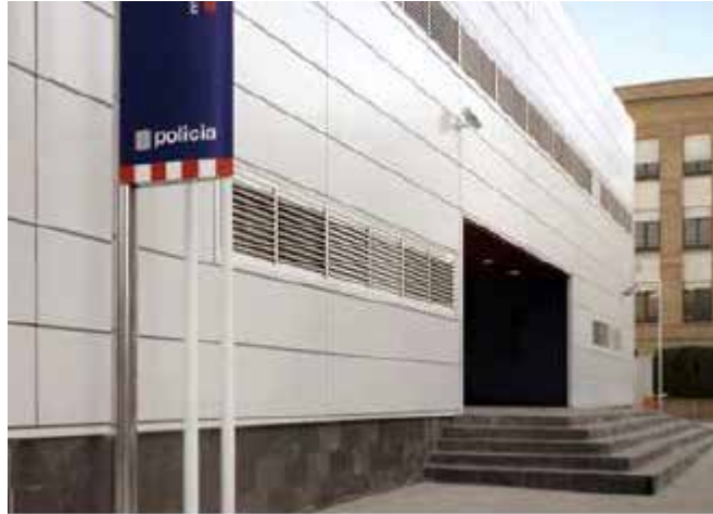
Figura 9: Vista frontal del centro. Fuente http://www.plataformaarquitectura.cl/cl/733859/comisaria-de-mossos-desquadra-ravetllat-ribas-arquitectos , (2012)
