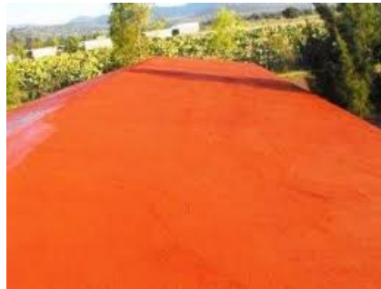
Figura 49: Losa con impermeabilizante acrílico. Fuente:
