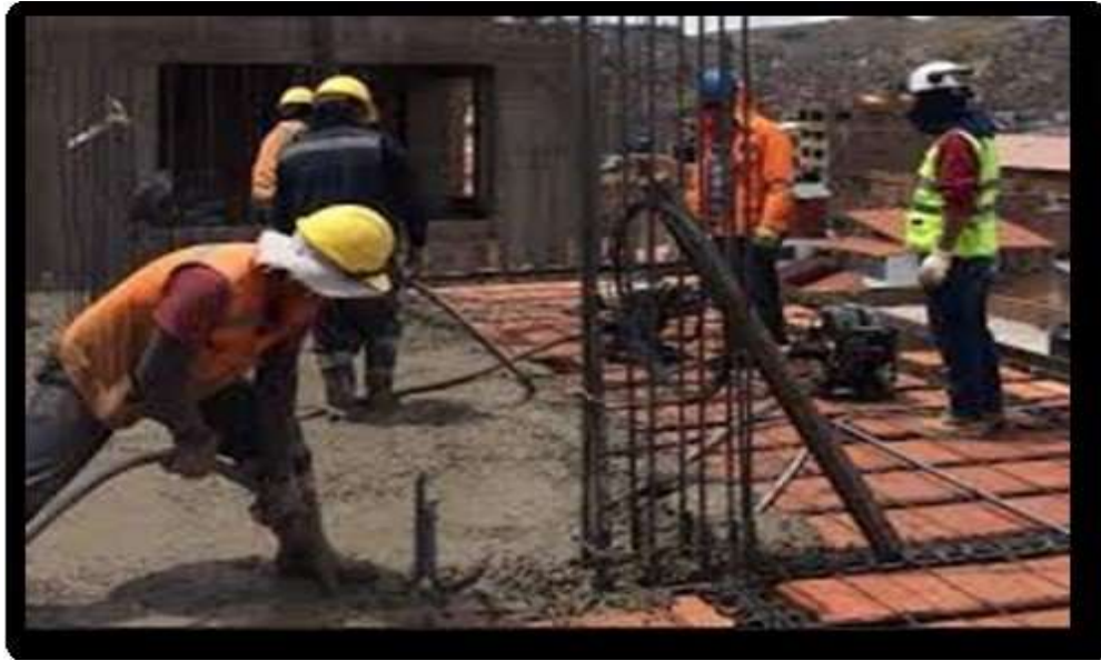
Figura 30. Vaciado de concreto.
