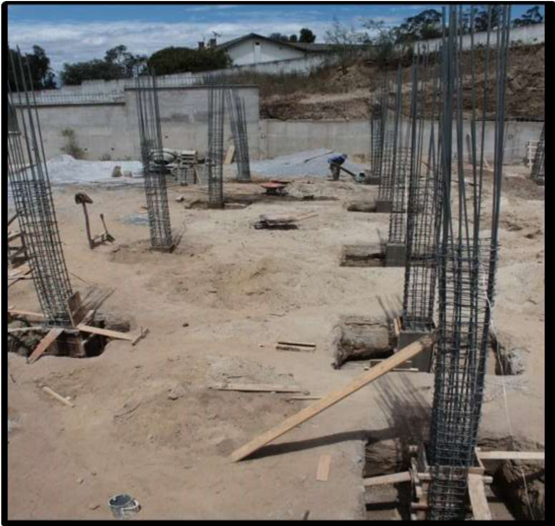
Figura 25. Colocación de acero en columna.
