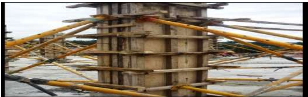
Figura 29. Encofrado de madera.
