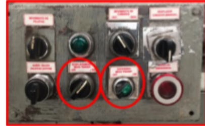
Imagen #2. Presione el botón de parada de emergencia.
