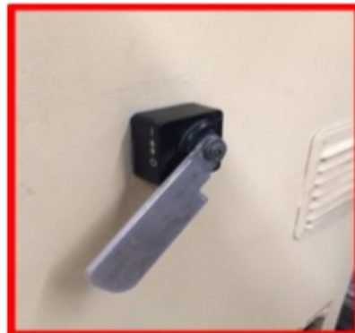
Imagen #14. Palanca de arranque en lateral del tablero.
