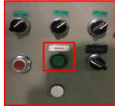
Imagen #5. Botón de reseteo en panel de control.
