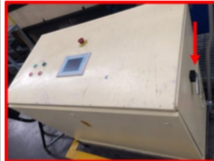
Imagen #13. Palanca de arranque en lateral del tablero.
