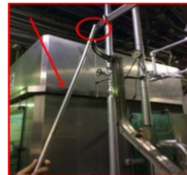
Imagen #7. Operador desatascando tapas con palanca metálica.
