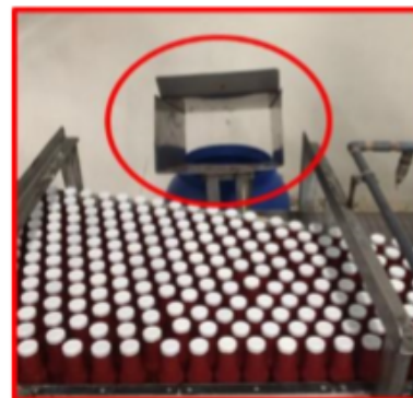
Imagen #8. Ducto para tambor de PNC.
