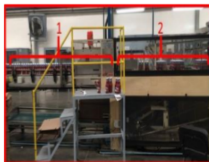
Imagen #16. Palanca de arranque en lateral del tablero.
