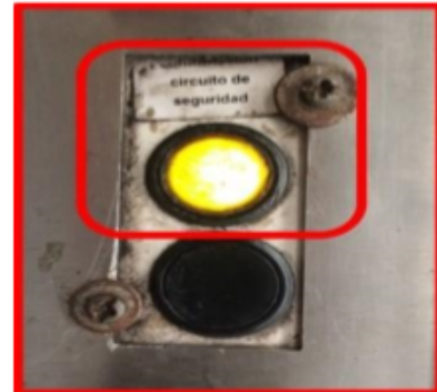
Imagen #6. Botón "Circuito de Seguridad".
