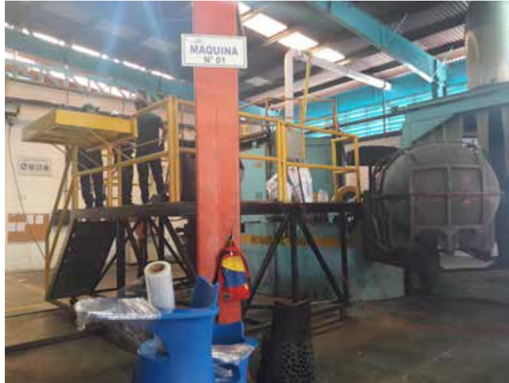
Figura 18: Desorden en el área de desmoldeo de maquina N°1. Fuente: Departamento de Producción Industrias Q'Productos, S.A. (2019).
